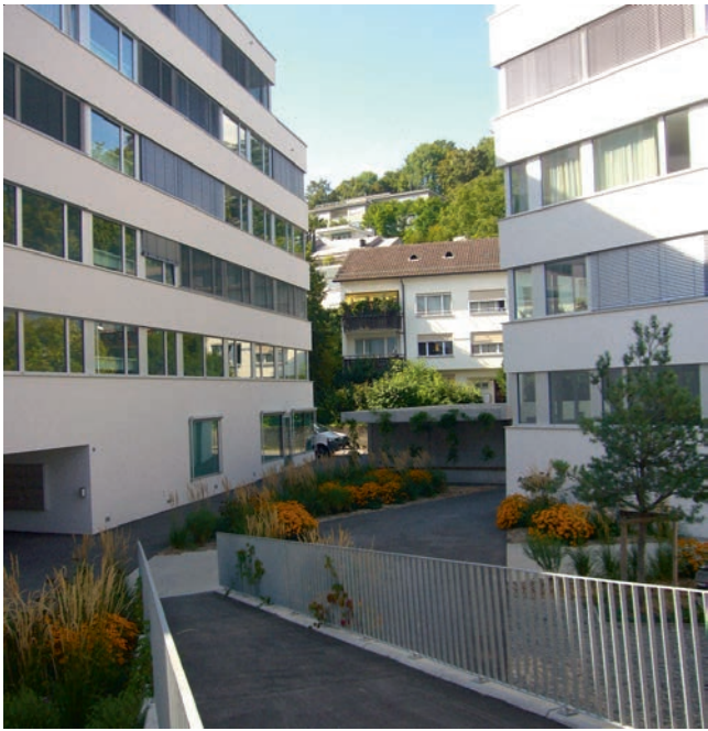
Wohnüberbauung Durachweg · Schaffhausen
